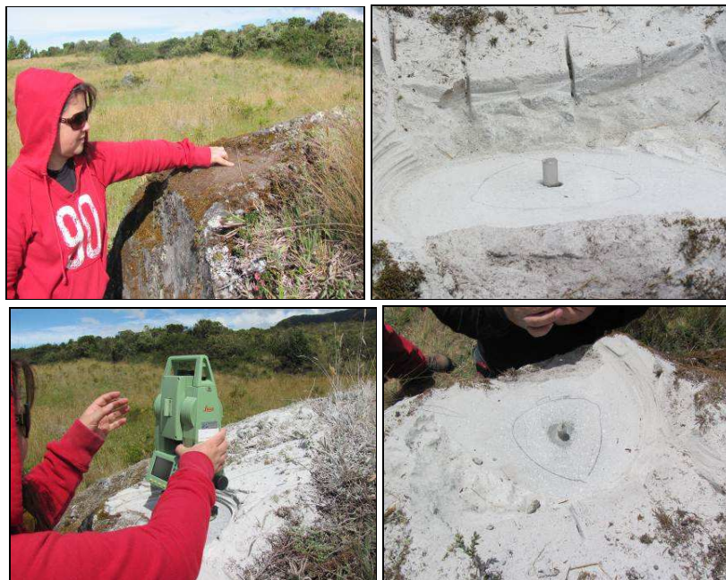
Figura 2.3.11. Imágenes de la construcción de la Base EDM Panamal en roca hacia el sector suroriental de Azufra.
